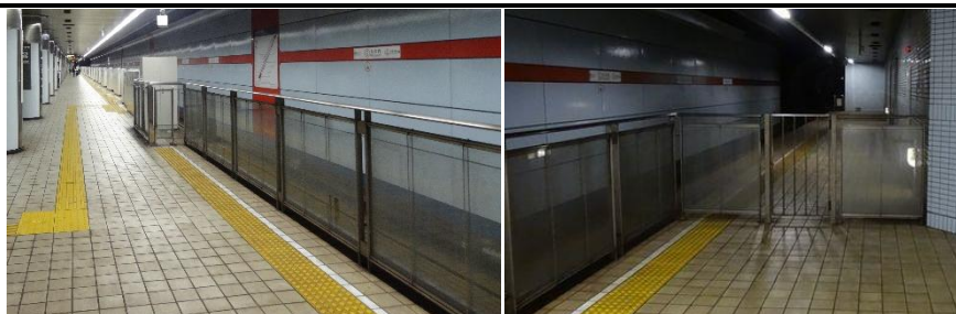
桜通線「丸の内」駅のホームの余裕部分の柵
