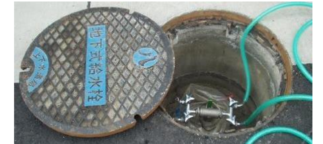
地下式給水栓
