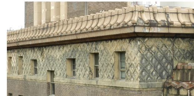
市庁舎全体に迷彩色を施した当時の写真(上)と、現在も跡のこる外壁部分(下)
